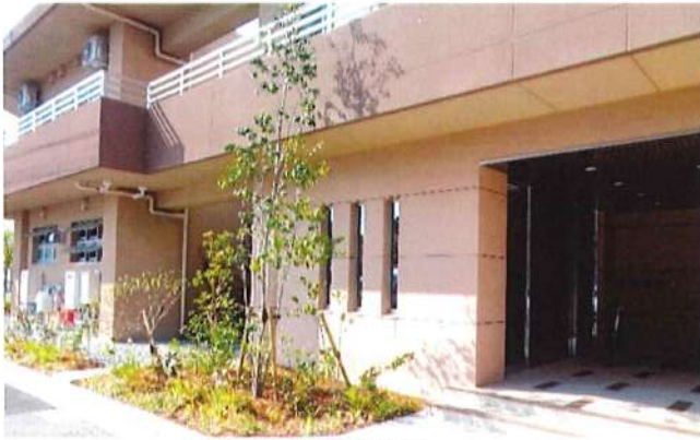
外観・玄関付近
